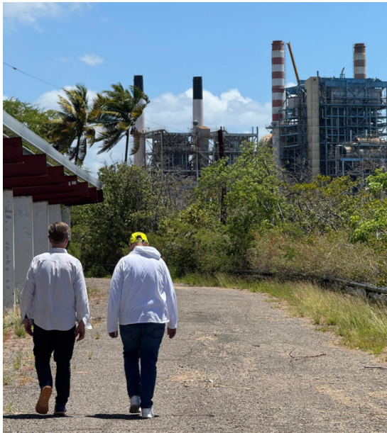
Thomas McAndrew, CEO de Enchanted y Eddie Echevarría, CEO de Power Expectation inspeccionando la planta de Costa Sur
