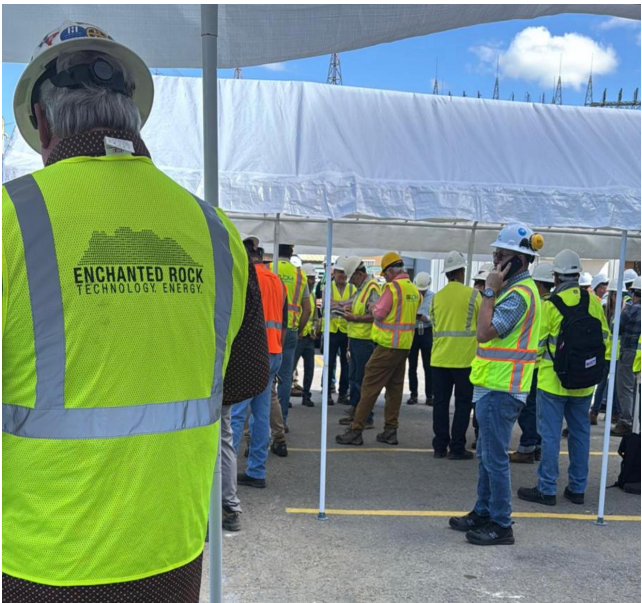
Empleados de Enchanted Rock inspeccionando las facilidades de la Autoridad de Energía Eléctrica
